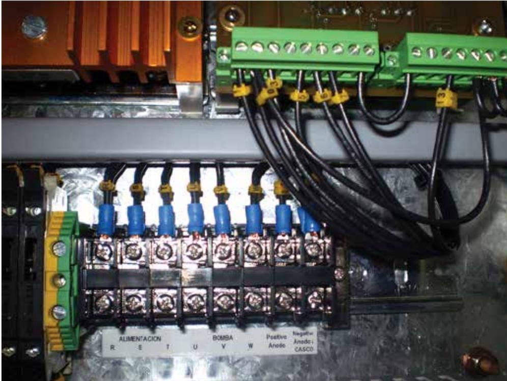
4. La bornera verde y amarillo es la de tierra debe conectarse al tablero principal a la barra de tierra; luego, las tres borneras (identificadas R, S, T) corresponden a las tres fases de la alimentación desde el tablero principal y deben conectarse a la protección termomagnética mencionada. Seguidamente se observan los tres borneras (identificadas (U, V, W) que son las conexiones para la bomba de circulación.
